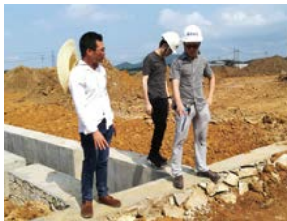
集团公司工程管理部业务人员现场查看项目建设进展
